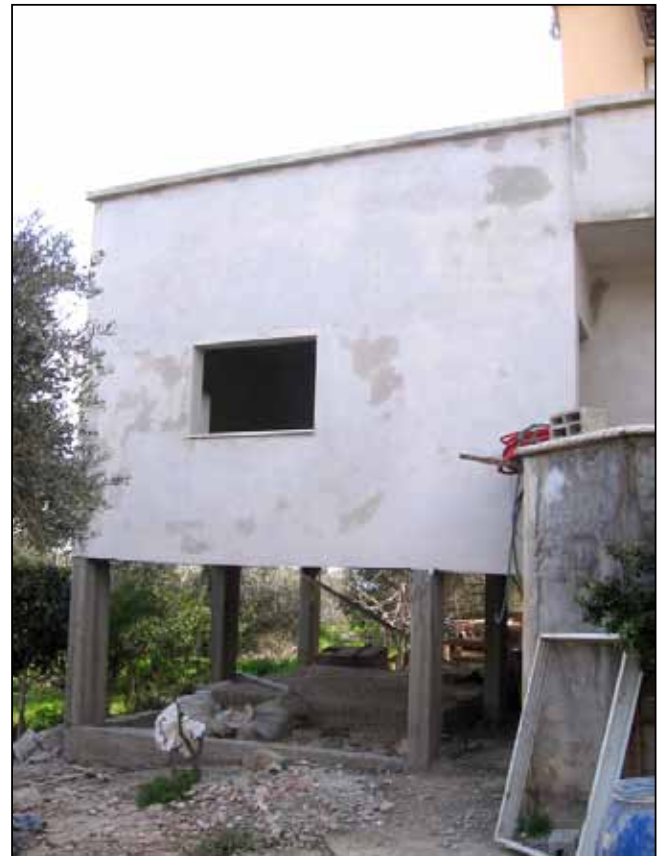
4 famiglie beneficiano dei lavori di ristrutturazione delle loro abitazioni
