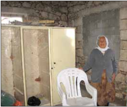
Lavori di rinnovo dell'appartamento di lustra
