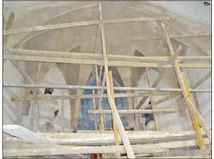
Lavori nella navata della chiesa
